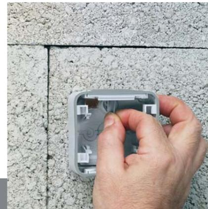
1/ Prédécoupe de l'embout en tirant sur l'opercule.
