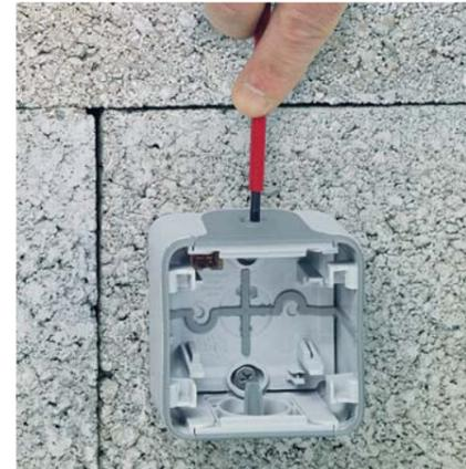
1/ Perforation de l'embout à l'aide d'un tournevis.
