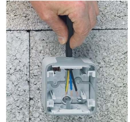
3/ La membrane de l'embout assure l'IP 55 de l'installation.
