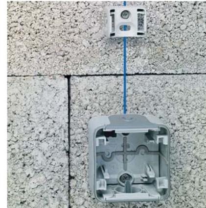
1/ Mise en place de la lyre et de l'appareillage sur le mur.
